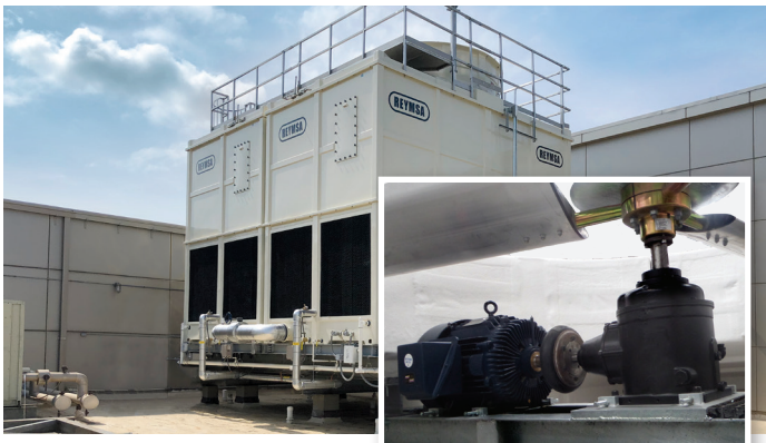
Modelos de un ventilador Estándar: Sistema de transmisión con caja reductora
