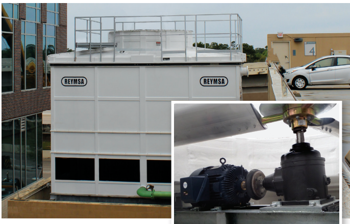
Modelos de un ventilador Estándar: Sistema de transmisión con caja reductora
