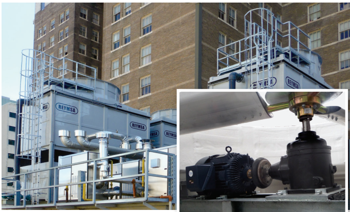
Modelos de un ventilador Estándar: Sistema de transmisión con caja reductora
