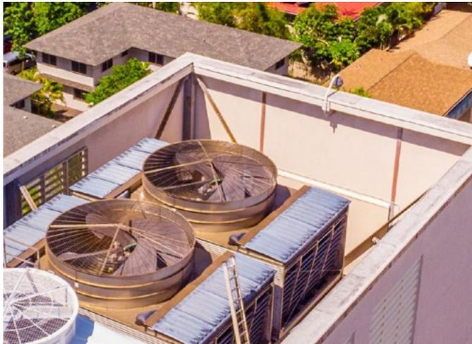
Con el tiempo, los equipos de ingeniería y mantenimiento del Centro de Convenciones de Hawái se habían frustrado con los gastos necesarios para reemplazar las piezas dañadas y las torres corroídas en un corto período de tiempo, debido al **ambiente salino** que destruye las torres a un ritmo mucho más rápido de lo normal. Además, los propietarios en estos entornos altamente corrosivos deben invertir dinero en mantener las torres antiguas recubiertas para protegerlas.
