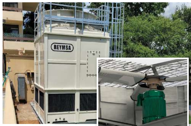
Torre con 1 ventilador Opcional: Sistema de transmisión directa
