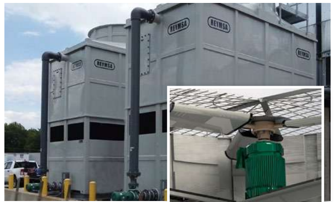
Modelos de un ventilador Opcional: Sistema de transmisión directa
