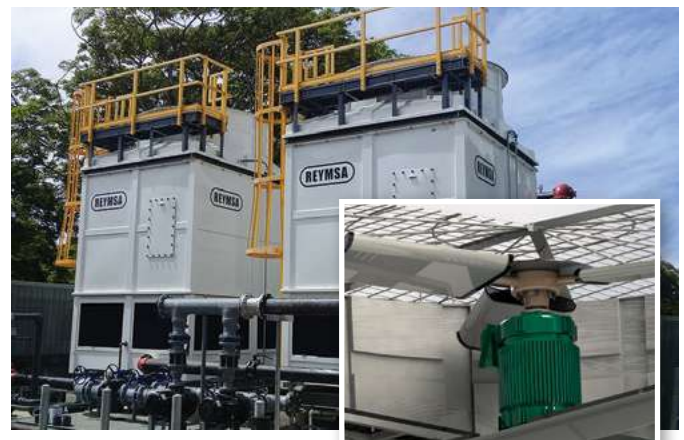
Modelos de un ventilador Opcional: Sistema de transmisión directa
