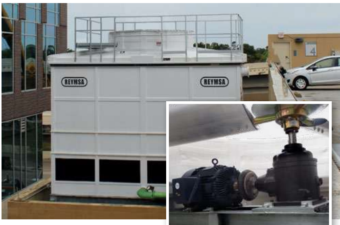
Modelos de un ventilador Estándar: Sistema de transmisión con caja reductora
