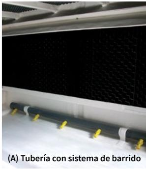
(A) Tubería con sistema de barrido
