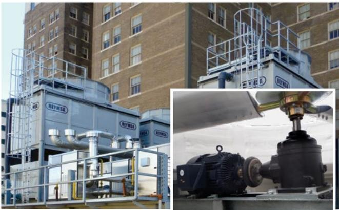
*Modelos de un ventilador
