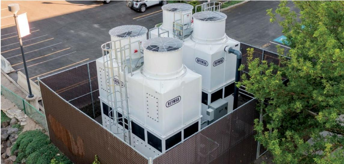
La torre de la Serie HFC es un Enfriador de Fluido de Circuito Cerrado, el cual rechaza la carga de calor del fluido de proceso por medio de un serpentín de cobre, el cual evita el contacto directo del fluido de proceso con los contaminantes del ambiente.
