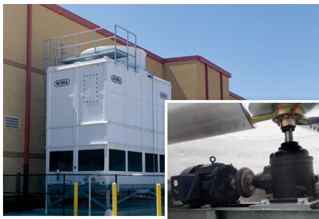
Torre de 1 ventilador Estándar: Sistema de transmisión con caja reductora
