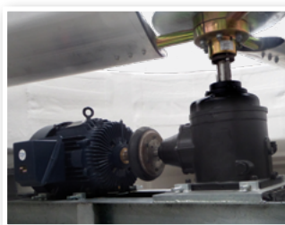
Estándar: Sistema de transmisión con caja reductora
